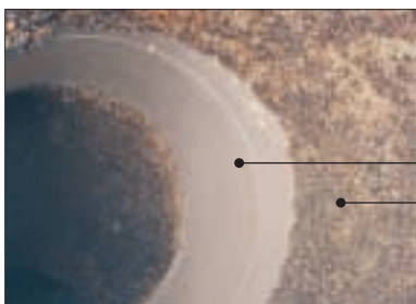
発電所循環水管内部（塗装後3年経過）
