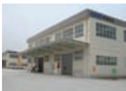
上海工場 新倉庫
