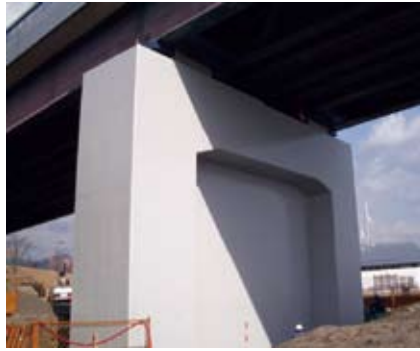
コンクリート橋脚
