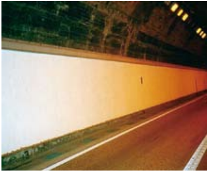
トンネル内面
