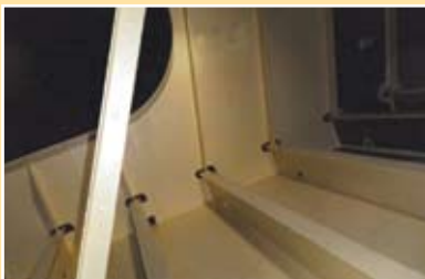
CMP NOVA SUPERECO 塗装
