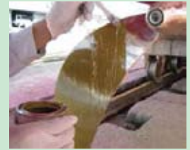
プライマー塗装
