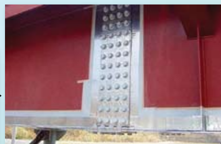
塗装後 5 年経過。 施工部に異常は見られません。
