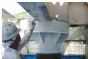
⑥ 中塗り (フローレックス中塗 EP MS)
