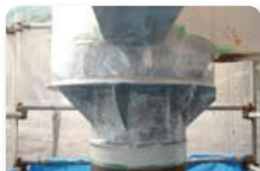
⑤ チタン箔専用プライマー塗装 (CMPチタンプライマー)
