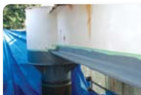
② 防食下地塗装 (エピコンジンク HB-2)
